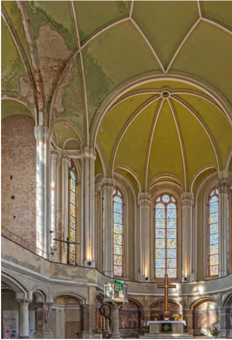
Der unsanierte Zustand zeigt deutlich die Schäden an Putz und Farbschichten oberhalb der Empore, die durch jahrzehntelange Feuchtigkeitseinwirkung entstanden sind
