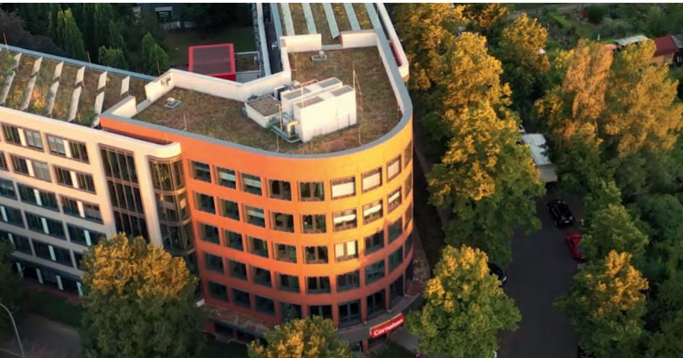
Das markante Verlagsgebäude an der Mecklenburgischen Straße
