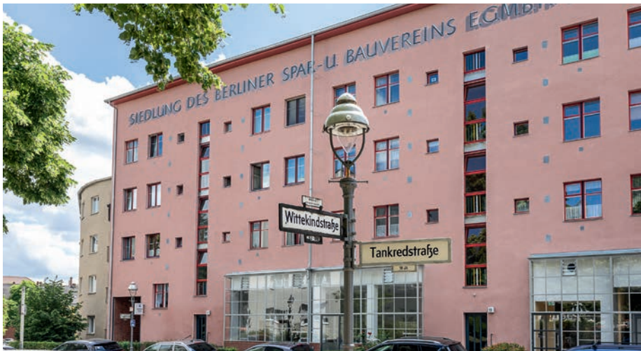
Umfangreichen Sanierung der Bruno-Taut-Siedlung „Attilahöhe“
