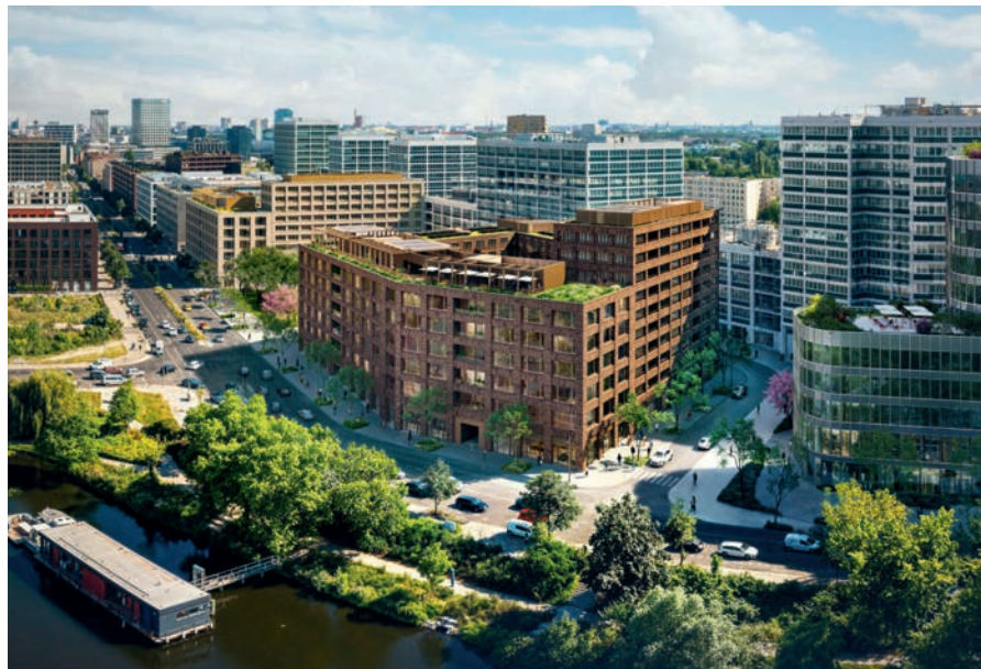
Der von gmp Architekten entworfene Gebäudekomplex „Nordhafen Living & Office“ ist Teil der Europacity, einem der größten innerstädtischen Entwicklungsgebiete Berlins
