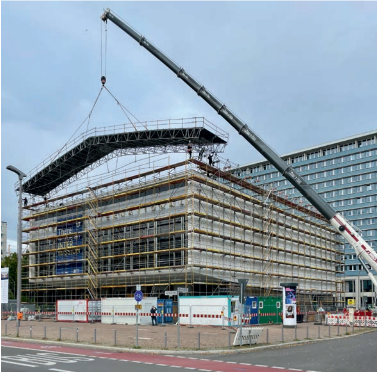
Montage des Wetterschutzdachs per Kran an der Karl-Marx-Allee, Oktober 2024
